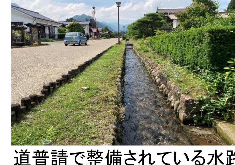
道普請で整備されている水路
